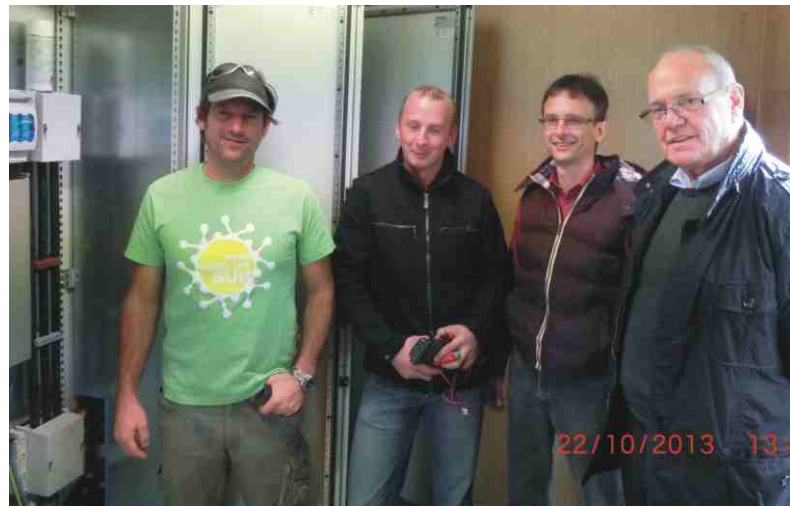
Inbetriebnahme der PV-Anlage:
