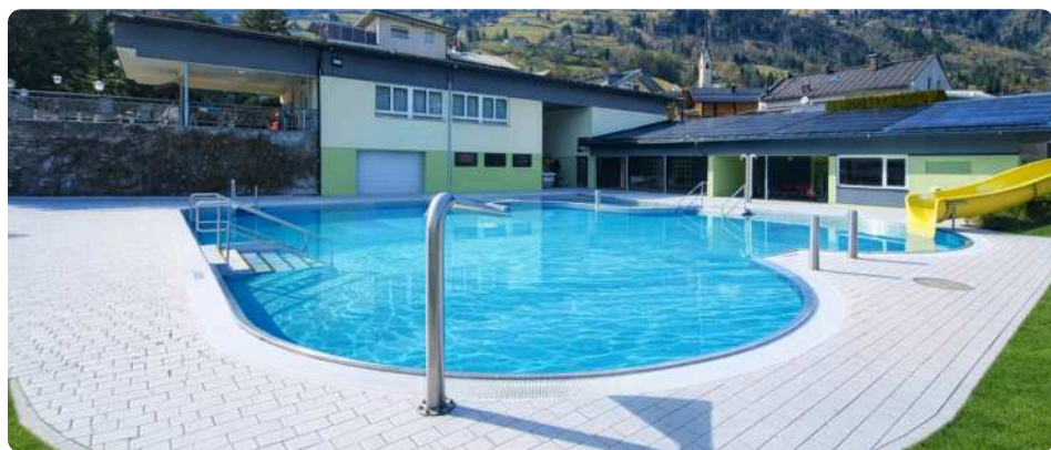
Sanierteres Schwimmbadgebäude mit PV-Anlage, neuer Pflasterung und modernen Sanitäranlagen. Die Montage der Umkleiden und Spinde erfolgt Mitte April.
